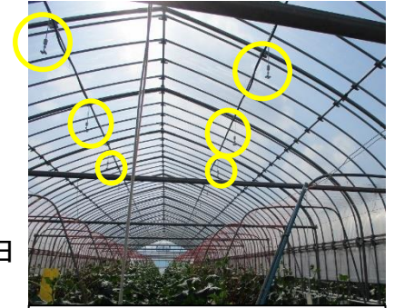
図1 簡易ミスト設置状況
