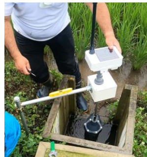
図1 自動バルブ設置の様子
